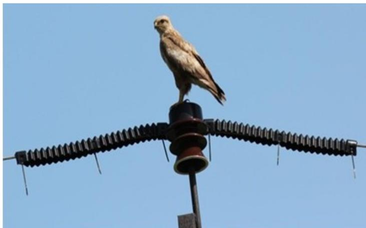
Рис. 2. Птицезащитные устройства контактного типа
