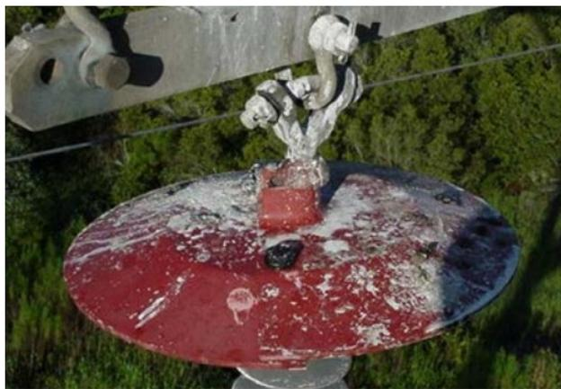
Рис. 1. Загрязнения биологическими отходами изоляторов
