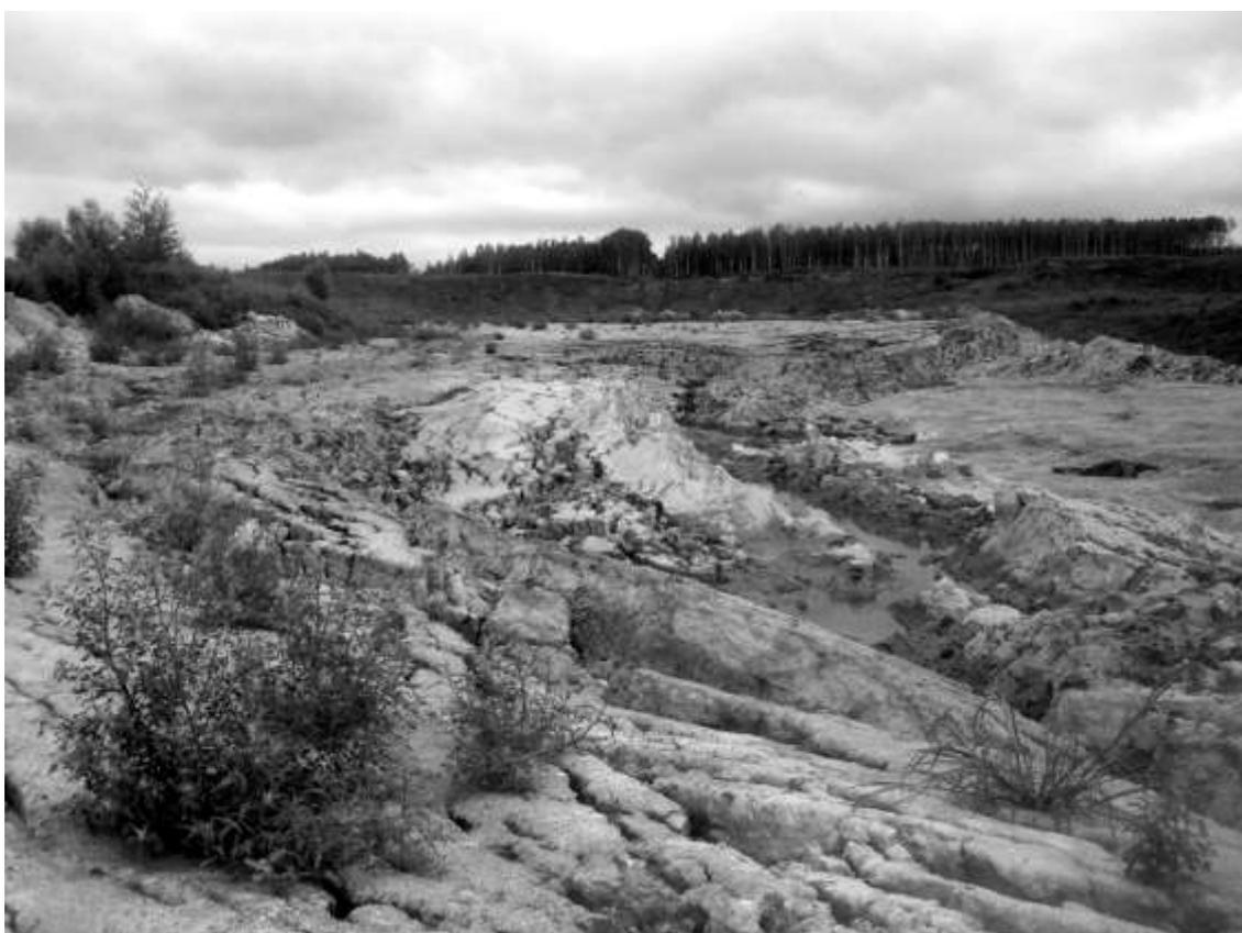
**Рис.2. Отвал вскрышных пород с характерными ступенчатыми сбросами и трещинами растяжения в тылу оползня**
