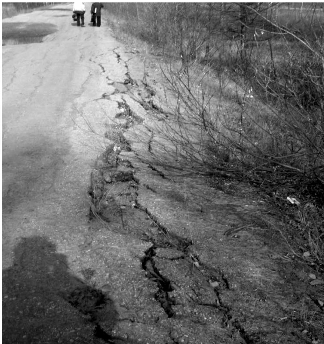
**Рис. 3. Трещины в полотне шоссейной дороги, образовавшиеся в результате просадки грунтов в болотистой местности**
